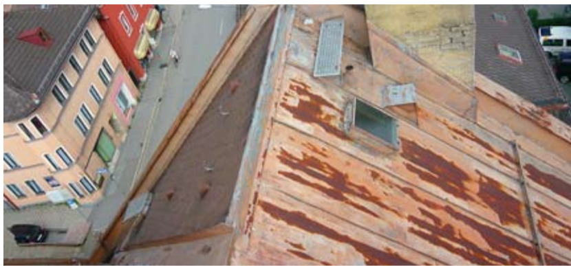
Dach vor der Sanierung im damaligen Zustand.
