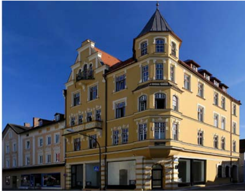
Historische Kastenfenster – energetisch renoviert.
